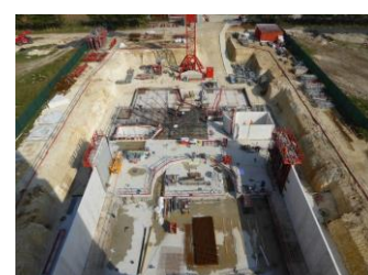
Le site du chantier John Monash
